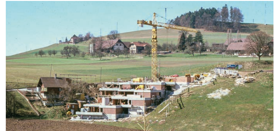
Die erste Etappe im Bau, 1977.
