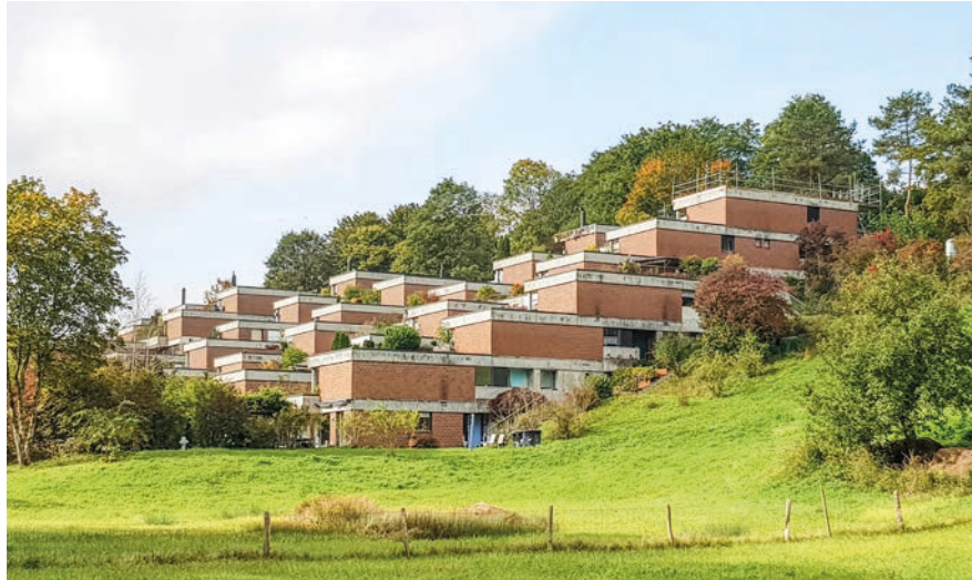
Blick vom Gäbelbachtal auf die Terrassenhäuser der dritten Etappe, von Osten.
