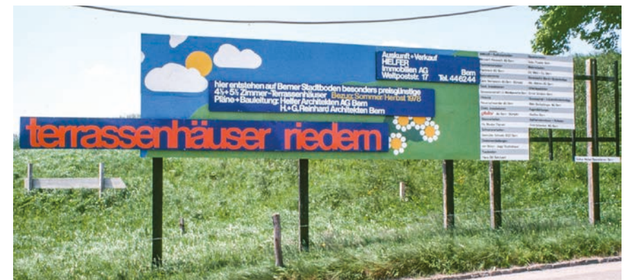
Mit bunt gestalteten Baustellentafeln wurde für die «besonders preisgünstigen» Terrassenhäuser im Riedernrain geworben.
